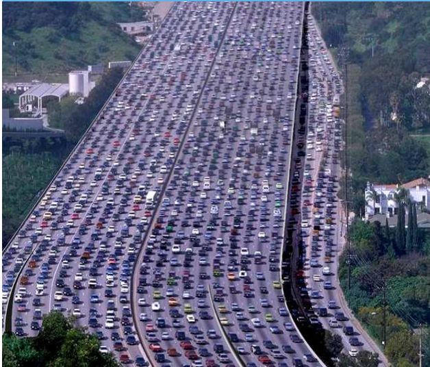
Rodoviário terrestre (IMT/IEMA)
